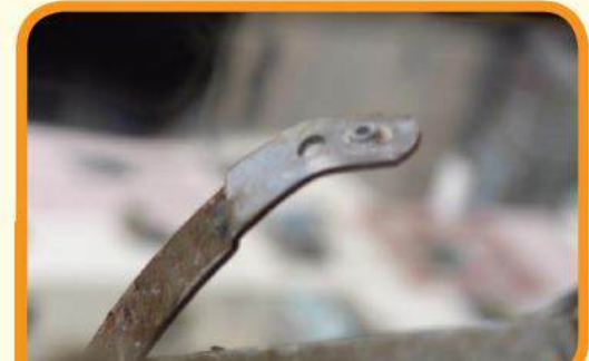
Bent or loose bar hinges
