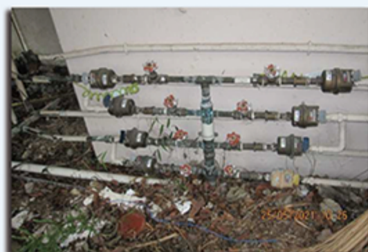
更換已損壞的水掣和防回流裝置、已破損食水喉管及糾正錯誤接駁喉管
