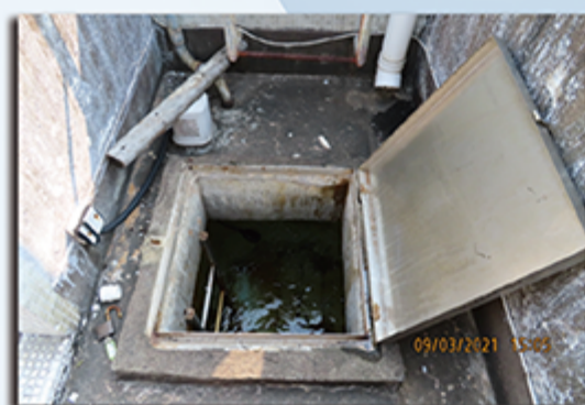
更換成可鎖上的緊合複式水缸蓋，及資助定期清洗食水貯水缸
