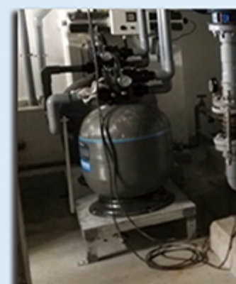
更換已損壞的水泵和增壓泵
